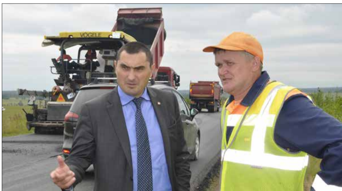
Директор ООО «Дорос» И. Панфилов и производитель работ А. Пестов обсуждают ход строительства дороги Чернушка – Тюш.
