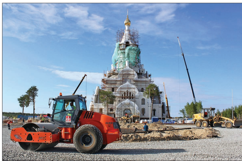
Работники ООО «Дорстройсервис» ведут строительство автодороги у храма Святой Мученицы Татианы в г. Когалыме.
