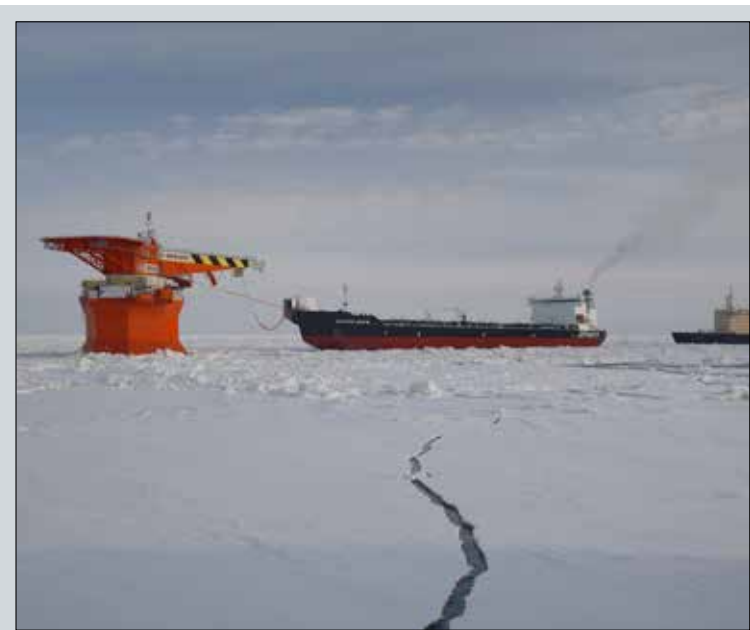
Стационарный морской ледостойкий отгрузочный причал Варандей состоит из двух частей — опорного основания с жилым модулем на 12 человек и технологическими системами, а также поворотного швартово-грузового устройства со стрелой и вертолетной площадкой. Высота причала более 50 м, общий вес — 11 тыс. тонн. В комплекс входят береговой резервуарный парк вместимостью 325 тыс. м 3 и две нитки подводного нефтепровода диаметром 820 мм и протяженностью более 22 км. Производительность комплекса — 12 млн тонн в год.
