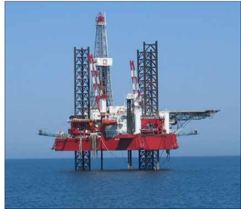
Самоподъемная полупогружная буровая установка «Астра» представляет собой трехопорную платформу с высотой опорных колонн 66 м. Установка позволяет проводить буровые работы на море с толщей воды до 45 м и глубиной скважин до 5 тыс. м.
