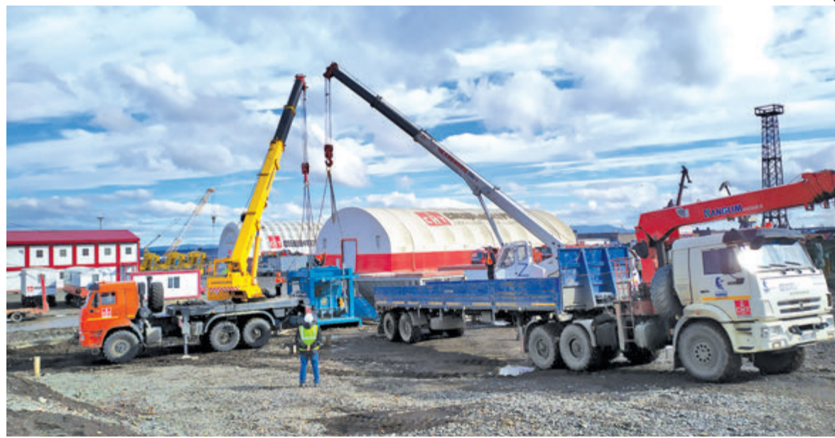
➤ На базе ООО «ДТК Ямал» идет погрузка бункера асфальтобетонного завода.
