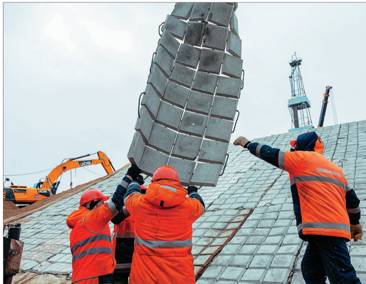
Дорожники ЗАО «Транс-Строй» завершают работы по обустройству буровой площадки.
